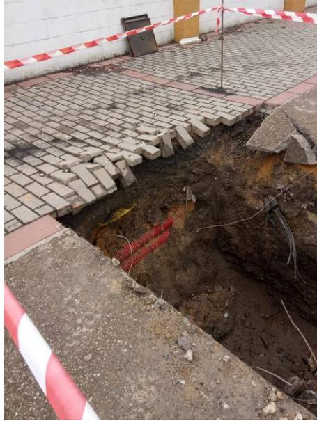
Análogamente, en la esquina entre C/Alfarería y C/Salvador Allende, se constata la excavación de una zanja corrida con trayectoria zizagueante para la cimentación de un muro, en un terreno similar con aspecto de antiguo suelo de labor, también inundado por las precipitaciones caídas en los últimos días.
