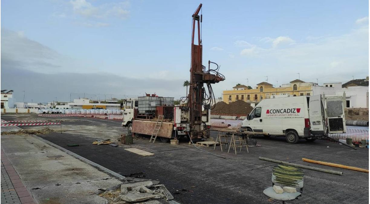
Emplazamiento de la sonda testiguera a rotación en el punto reseñado como SR-1.
