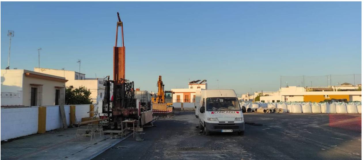
Emplazamiento de la sonda testiguera a rotación en el punto reseñado como SR-2.
