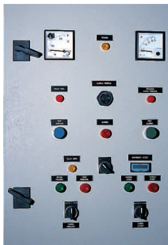
8. FRENTE DEL CUADRO DE CONTROL, MANDO Y PROTECCIÓN DEL GRUPO DE PRESIÓN DE LAS BIE.
