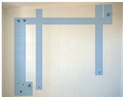
23. Bandas por donde discurren las instalaciones. Cocina.
