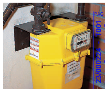
21. CONTADOR INDIVIDUAL Y LLAVE DE CORTE.
