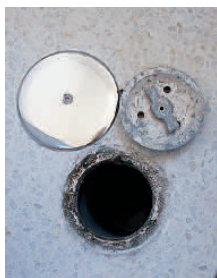
10. BOTE SIFÓNICO CON TAPA DESMONTADA.
