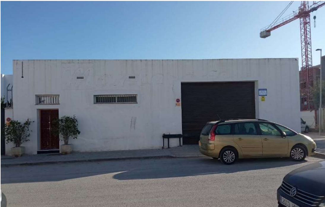
FACHADA A CALLE MANANTIAL
